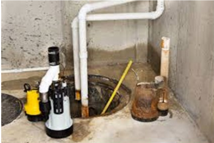
Corrosion d'appareils (pompe immergée)
