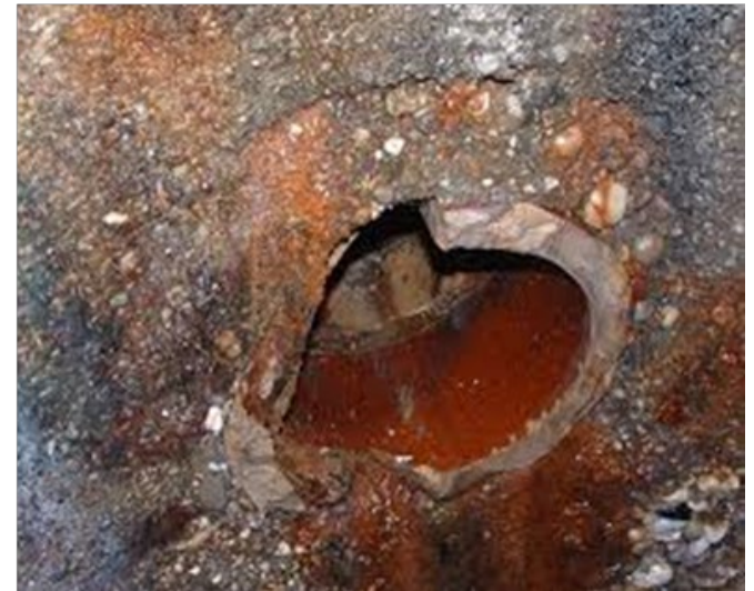
Corrosion du béton
